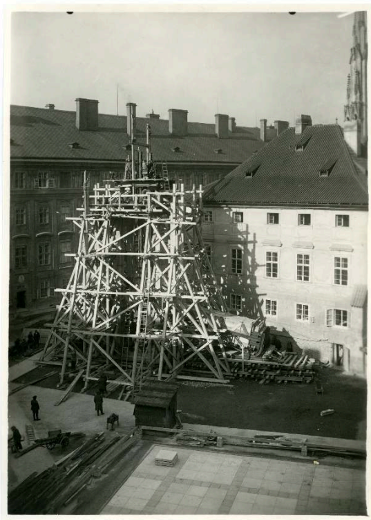
Illustration 3 : Les travaux de l'installation de l'obélisque dans la troisième cour de château de Prague, 1928
